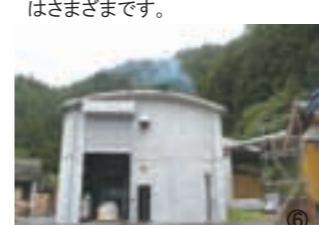
⑥ 樹皮や木くずを生のまま燃やすボイラーの建屋です。
